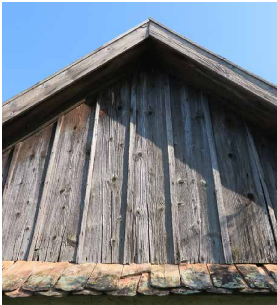
Széles fenyődeszkával borított tetőszerkezet, a deszkák hézagait lécekkel fedték. A deszkázat síkja elé ugró külső falsíkgig a tetőhéjazat anyagával azonos hódfarkú cserép falborítás készült.
