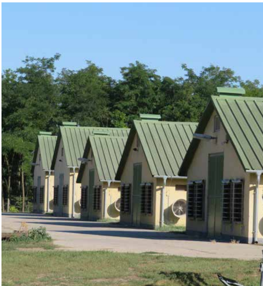
Kortárs példa: Fegyelmezett, a tartástechnológiai követelményeknek szigorúan megfelelő üzemi épületek, építési vonalra telepített beépítés (baromfitelep, Jászszentlászló)
