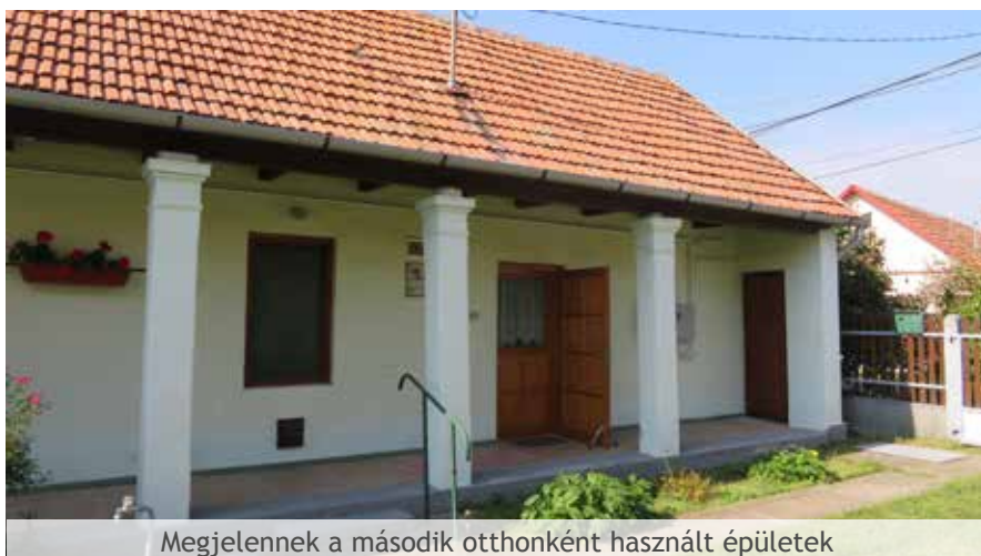
Szép állapotban megmaradt tornácos lakóház
